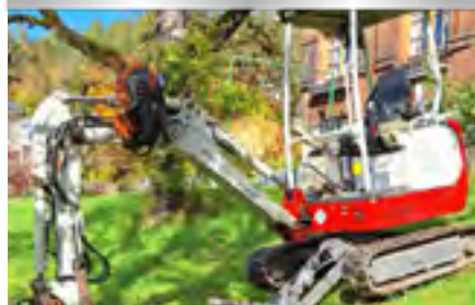
Sapi-vinsch på grävmaskin
